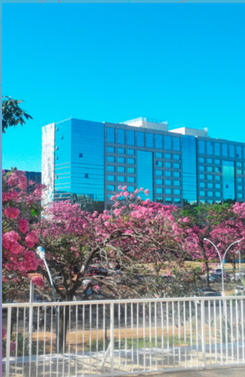
Edifício Matriz II, em Brasília
